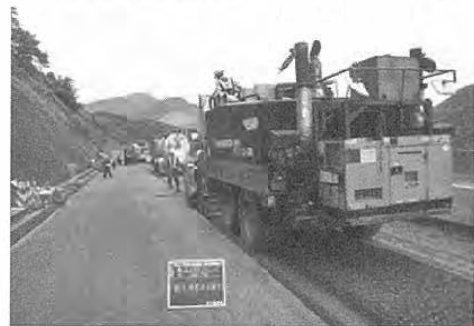
写真-2 FAの施工状況
