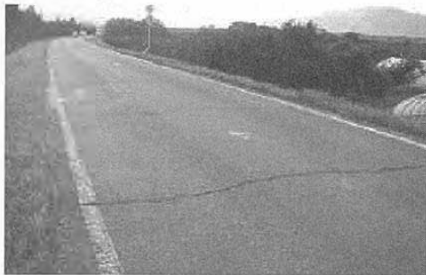
写真-1 施工前の路面状況
