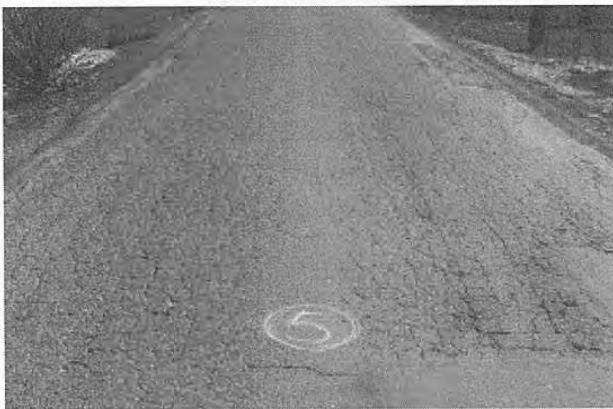
写真-8 施工前の路面性状
