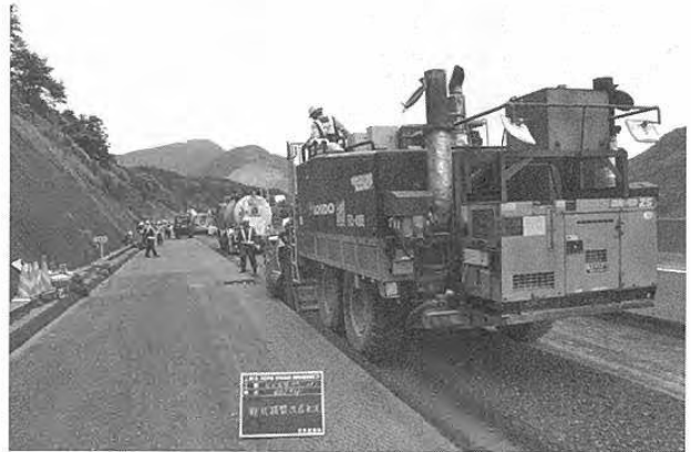
写真-10 施工状況
