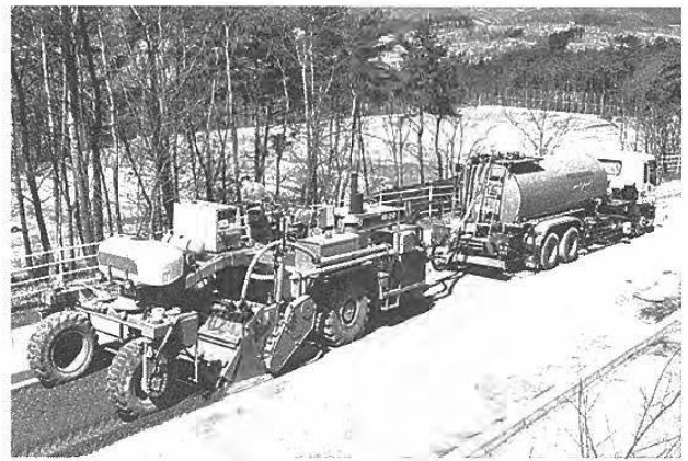
写真-2 路上破砕混合機(供給車併走タイプ)
