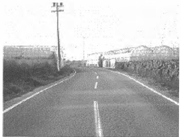
写真-6 施工前の路面性状
