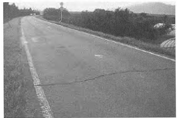
写真-4 施工前の路面性状
