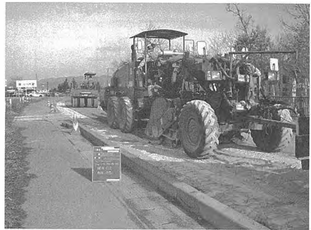
写真-5 防塵固化材の使用状況
