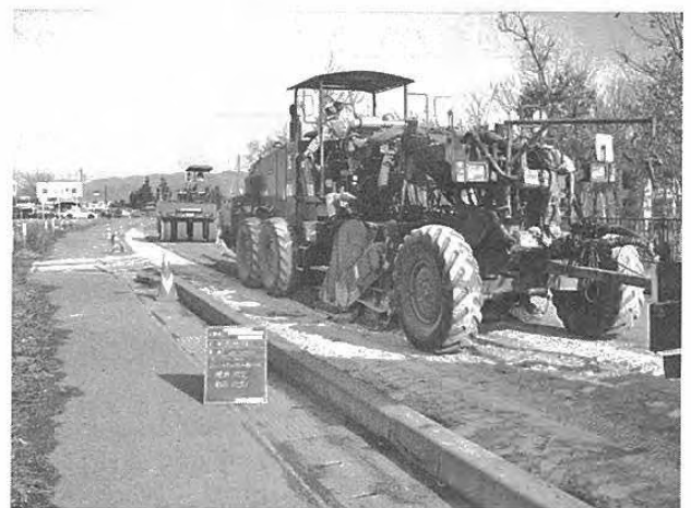
写真-7 施工状況
