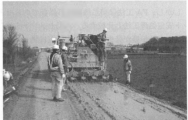
写真-9 セメントスラリーの散布状況
