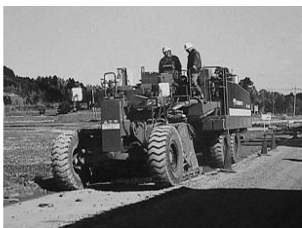
写真－２ 路上破碎混合機（単独施工タイプ）
